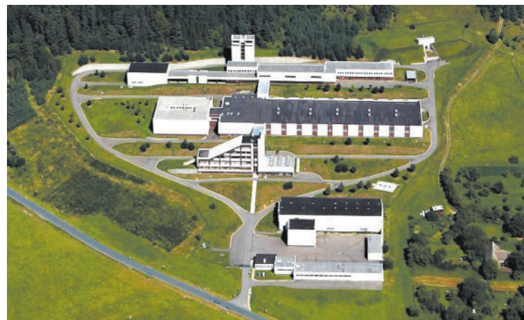
ÚPRAVNA VODY Švařec v Koroužném.
