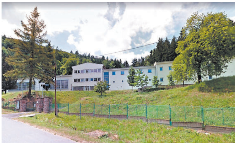
ÚPRAVNA VODY Víř slouží více než 60 let.
